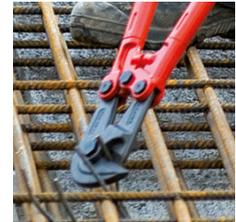
Особая форма головки ножниц для резки арматурной сетки 71 82 950 позволяет резать плотно прилегающую арматуру
